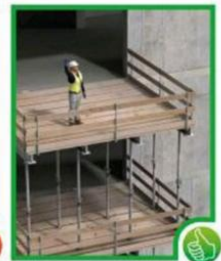
Bodenöffnungen schließen und Steckseisen umbiegen
