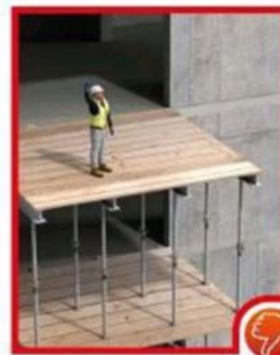
Bodenöffnungen schließen und Steckseisen umbiegen
