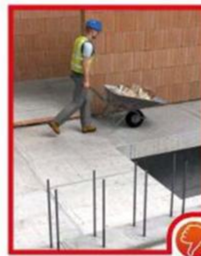
Bodenöffnungen schließen und Steckseisen umbiegen
