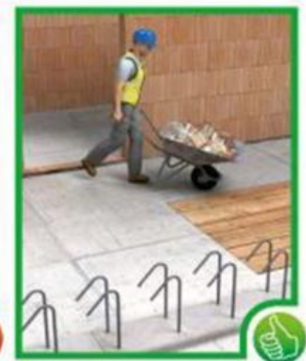
Bodenöffnungen schließen und Steckseisen umbiegen
